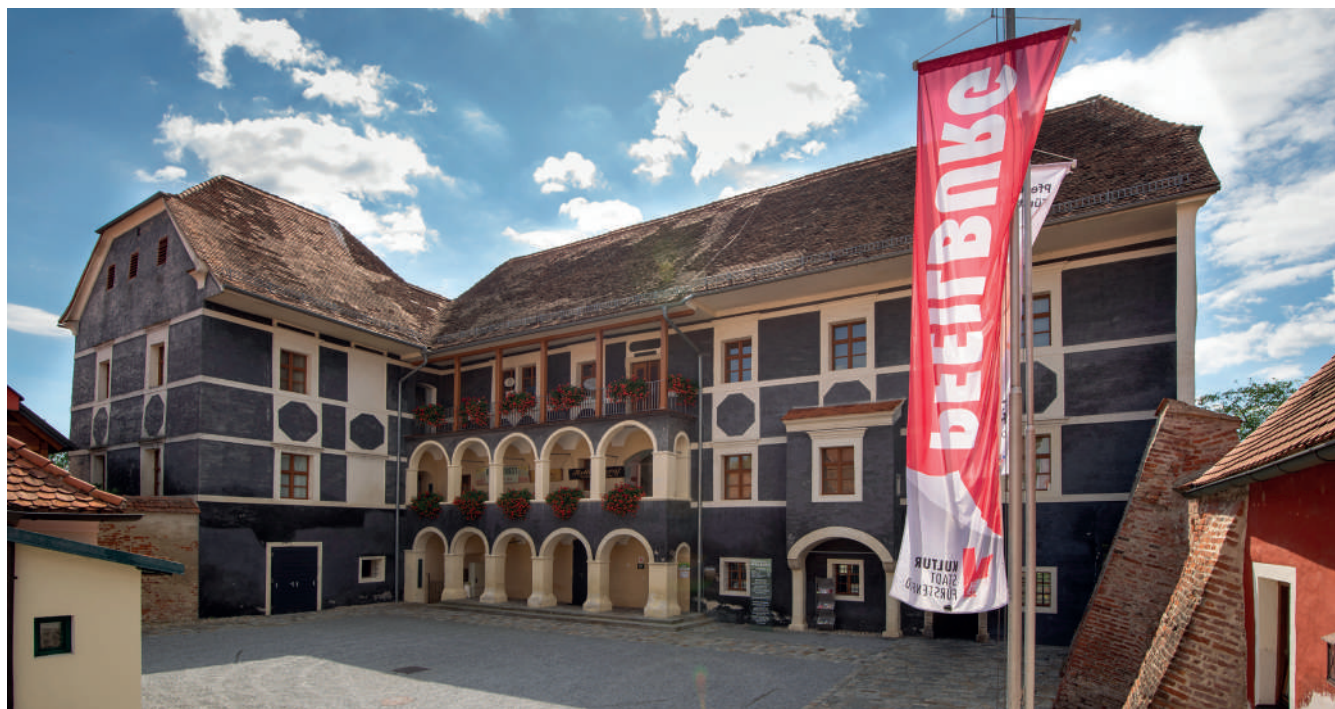
Innenhof der renovierten Pfeilburg.
