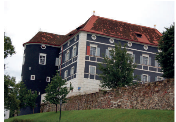
Schloss Aichberg mit der renovierten Fassade.
