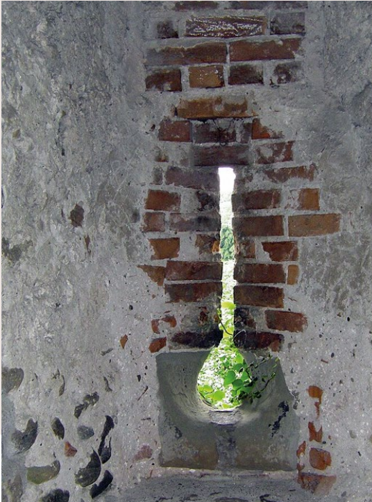
Inzwischen vermauerte gotische Schlüsselschießscharte am Grazer Schlossberg. Foto: © Diether Kramer 1993
